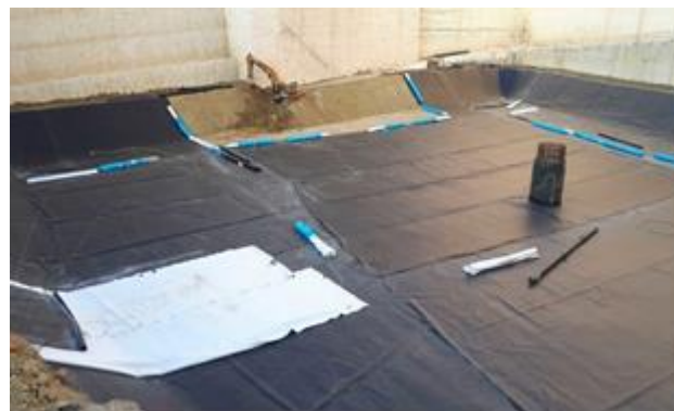
Fasi di allestimento fondo della discarica – Impianto Minervino Murge Fonte dati: Ufficio Tecnico di Progettazione
