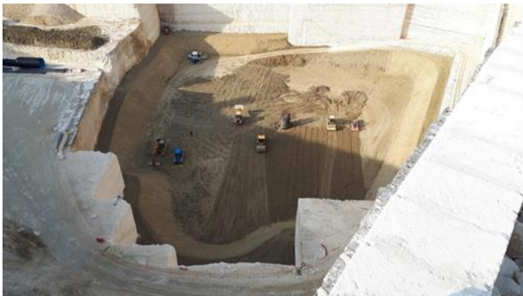
Fasi di allestimento fondo della discarica – Impianto Minervino Murge Fonte dati: Ufficio Tecnico di Progettazione
