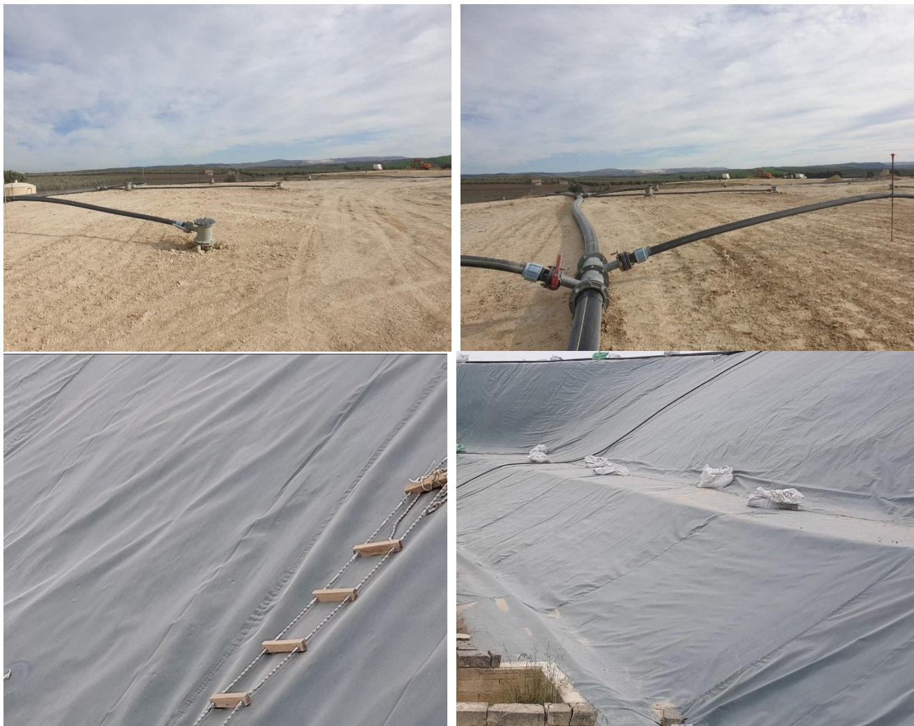
Dettagli fotografici sistemi di gestione percolato e particolare della copertura provvisoria impianto Canosa di Puglia
